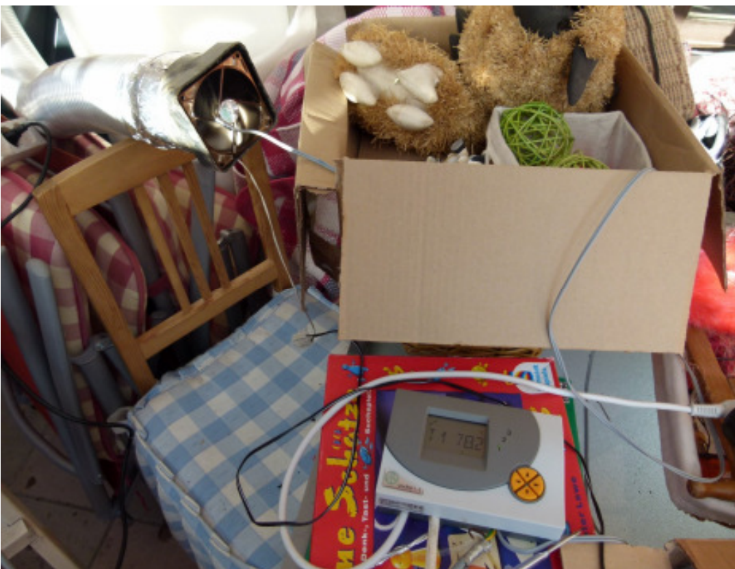
Lediglich der Alu- Schlauch liegt für den Testlauf auf der Terrasse und ist provisorisch an der Regelung angeschlossen.
